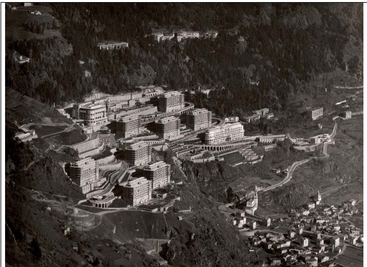
Villaggio Sanatoriale di Sondalo, foto della costruzione appena terminata (1938)
